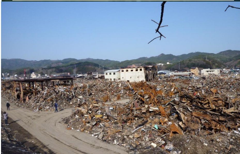
火災が発生し被害が拡大（気仙沼漁港）
