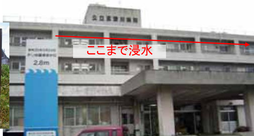
志津川病院(看板は2.8m、浸水痕は15m)
